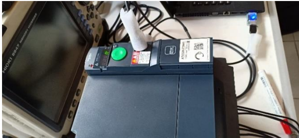
Gambar 3.2 Inverter sebagai penggerak motor induksi
