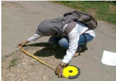
Gambar 3.4 Pengukuran dimensi kerusakan jalan
