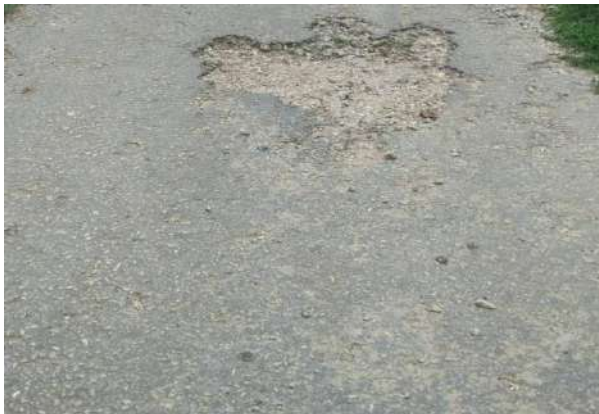
Gambar 1.3 Kondisi Lokasi Pengamatan
