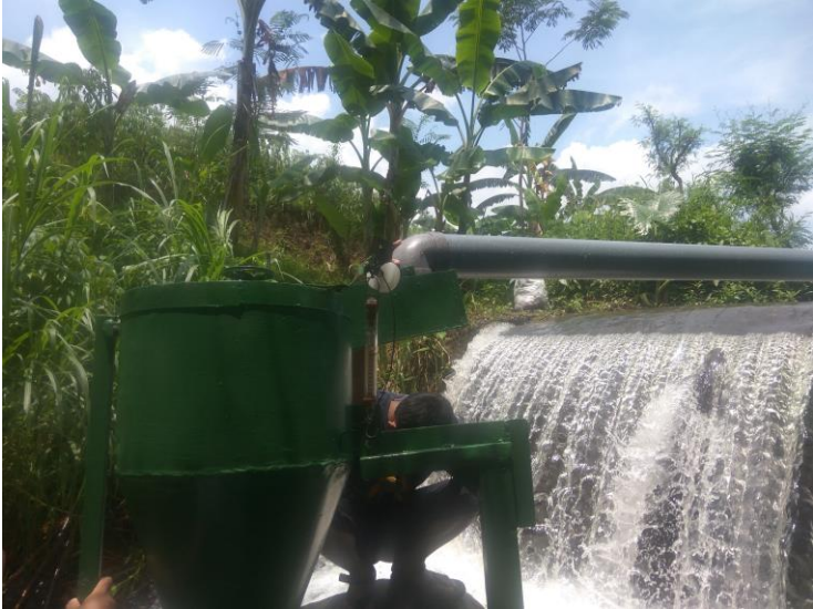
Pemasangan Pipa Alir dari Sungai ke Sistem Turbin
