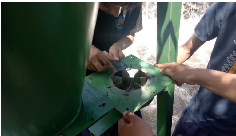
Pengaturan Sudut Guide Vanes
