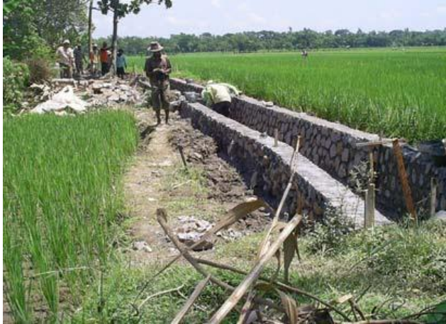
Gambar 4. 12 Pembangunan pasangan batu saluran irigasi Bacem (sumber : data)
