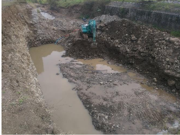
Gambar 4. 9 Pekerjaan dewatering dengan alat berat backhoe dan pompa
