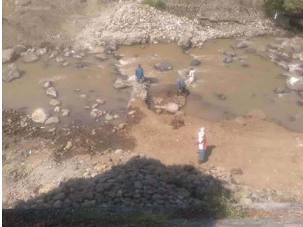
Gambar 4. 4 Pekerjaan pembersihan lokasi secara manual (Sumber : Data)
