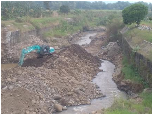
Gambar 4. 10 Pembuatan river diversion dengan material timbunan
