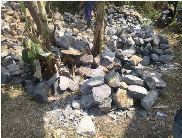
Gambar 4. 11 Pasangan batu yang akan digunakan ( sumber : data )
