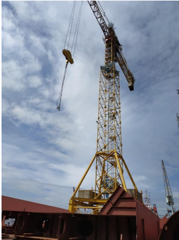
Gambar 4.20. Crane dengan kapasitas 60 ton
