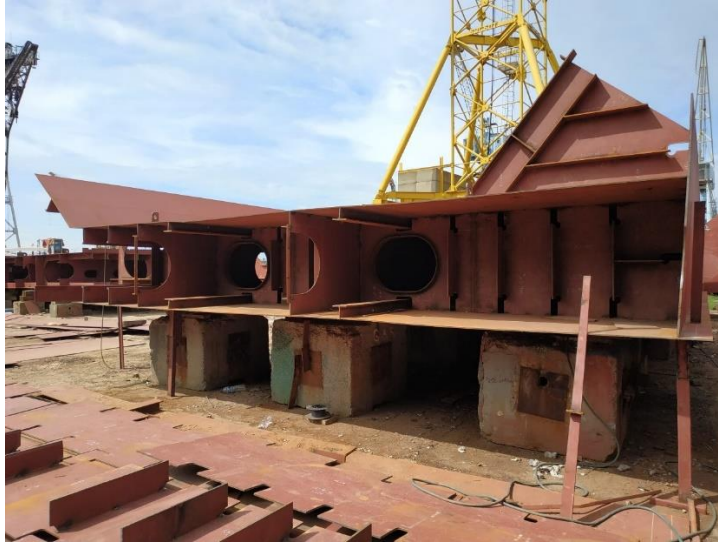
Gambar 4.17. Building berth yang sedang dilakukan pekerjaan
