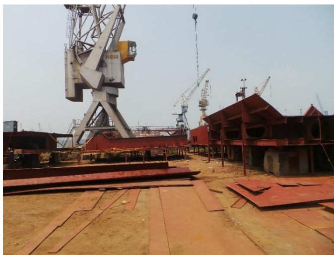
Gambar 4.19. Building Berth PT. Dok dan Perkapalan Surabaya
