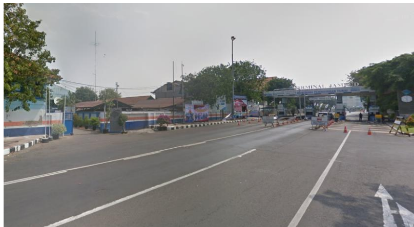
Gambar 4.3. Akses Pintu Masuk Utama PT. Dok dan Perkapalan Surabaya
