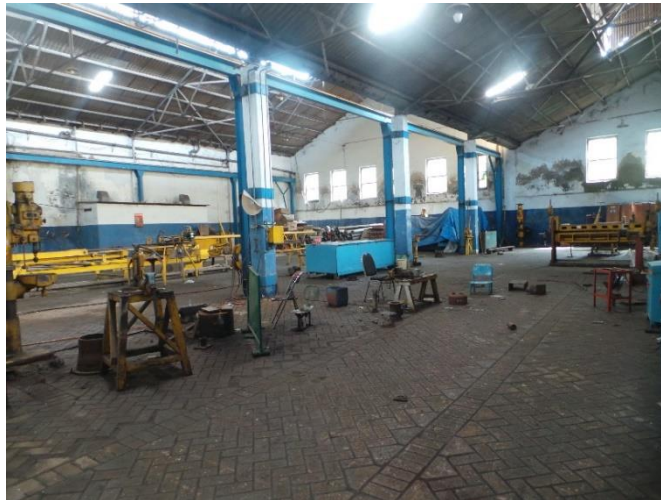
Gambar 4.10. Bengkel Pipa dan Ducting PT. Dok dan Perkapalan Surabaya
