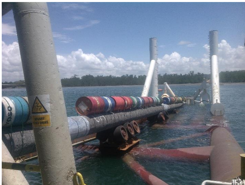
Gambar 1. 1 Proses instalasi pipa dengan metode Push Pull
