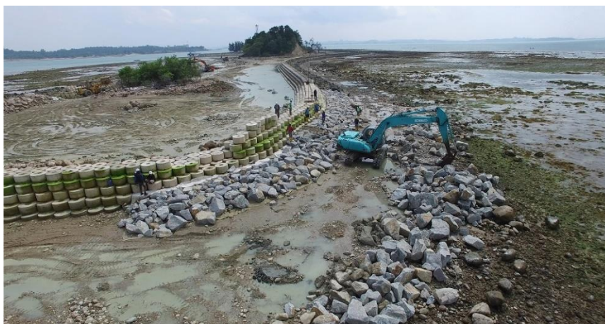
Gambar 1.1 Pemasangan buis beton sebagai seawall ( http://sda.pu.go.id )
