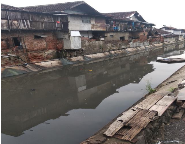
Gambar 3. 3 Kondisi Eksisting Penyaluran Air Limbah Sumber : Observasi Lapangan, 2019
