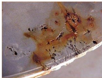
Gambar 2.3 Korosi Akibat Tegangan
