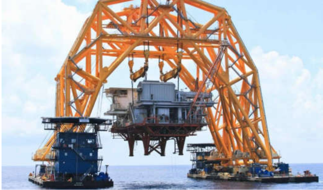
Gambar 2.2. proses pemindahan top side menggunakan HLV (www.google.com)
