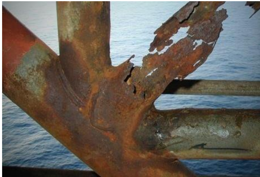
Gambar 2.12. Fatigue Corrosion
