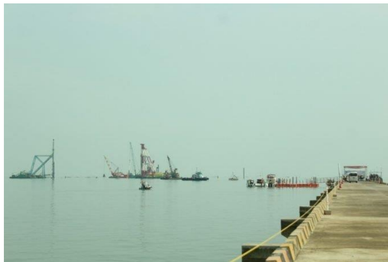
Gambar 1. 1 Pembangunan Pelabuhan Patimban
