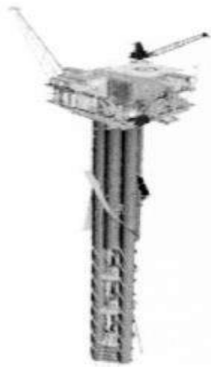
Gambar 2.9 Konstruksi Cell SPAR
