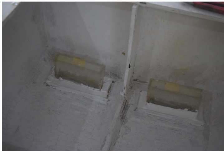
Gambar III.14 Pemasangan Injektor ke lambung kapal
