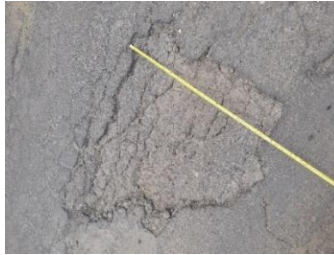
Gambar 4.2 Potholes (Berlubang)
