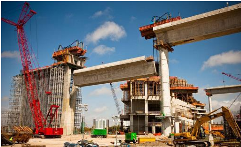
Gambar 2. 12 Metode full span menggunakan heavy lift (VSL International, 2012)
