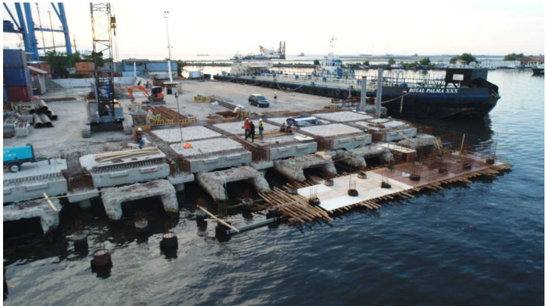
Gambar 4.2 Dokumentasi proyek pembangunan dermaga ‘X’
