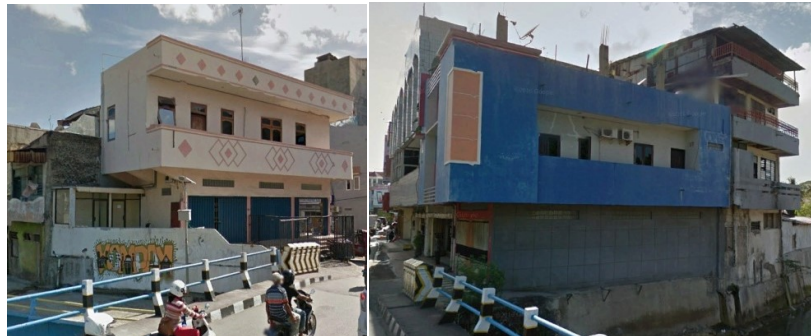
Gambar 4.22. Kondisi bangunan 2 dan 3 lantai di jalan Ikan Paus. (Sumber. Observasi, 2019)
