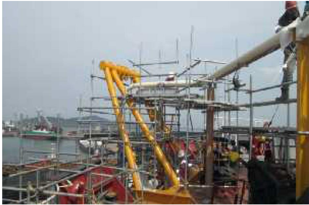
Gambar F.2 Pemasangan A-Frame
