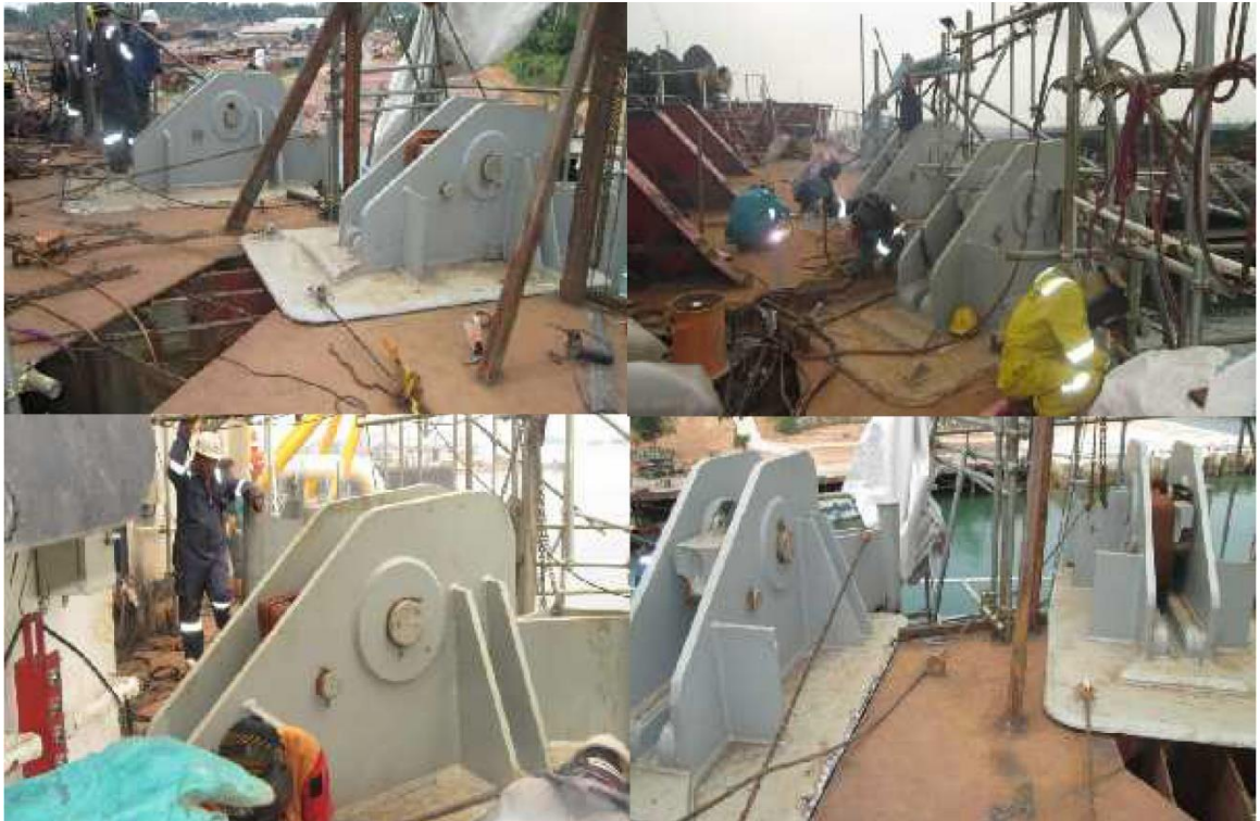
Gambar F. 3 Pemasangan Chain Stopper
