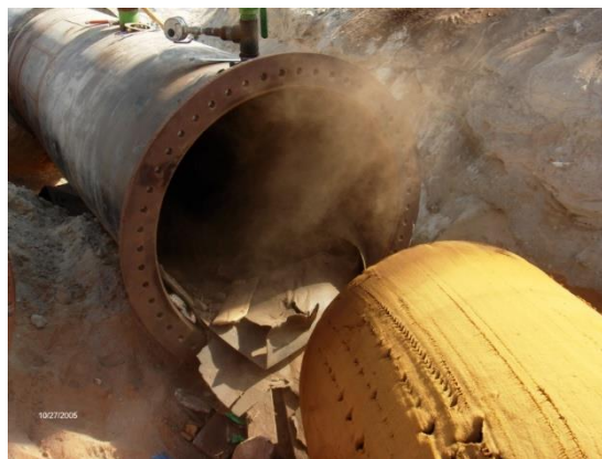
Gambar 2. 11 Terdapat Benda didalam Pipa
