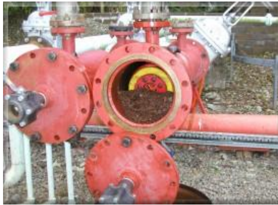
Gambar 2. 12 Kerak Dalam Pipa
