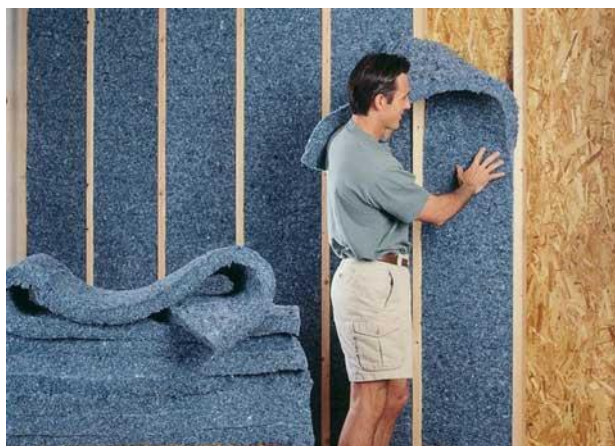
Gambar 2.1 Proses Pemasangan Peredam Suara (Sumber: peredamsuara-akustik.com )
