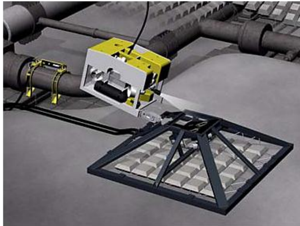
Gambar 2.7. Pemasangan anoda menggunakan ROV
