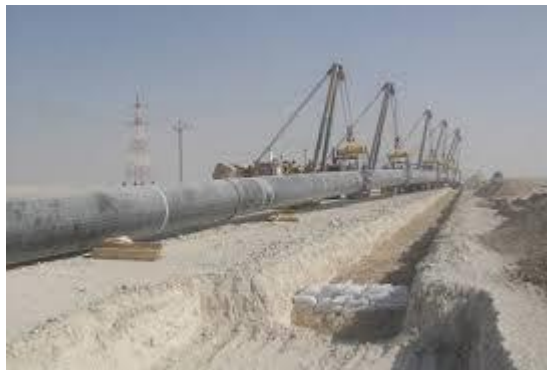
Gambar 2. 1 Proses pemasangan pipa gas
