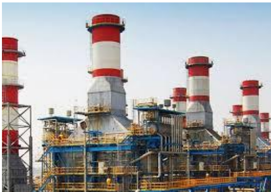
Gambar 2. 8 Pembangkit Listrik Tenaga Gas Uap Sumber : http://joss.co.id
