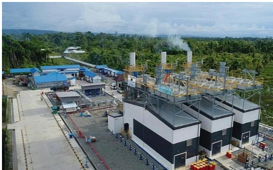
Gambar 2. 7 Pembangkit Listrik Tenaga Mesin Gas Sumber : http://nabire.net
