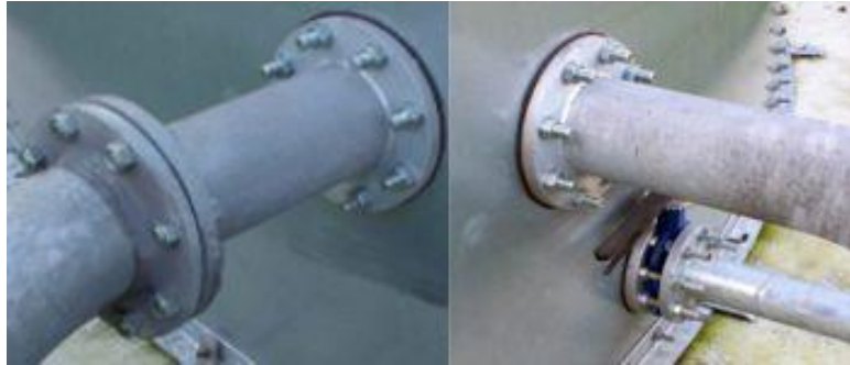
Gambar 4. 7 Instalasi pipa pada tangki
