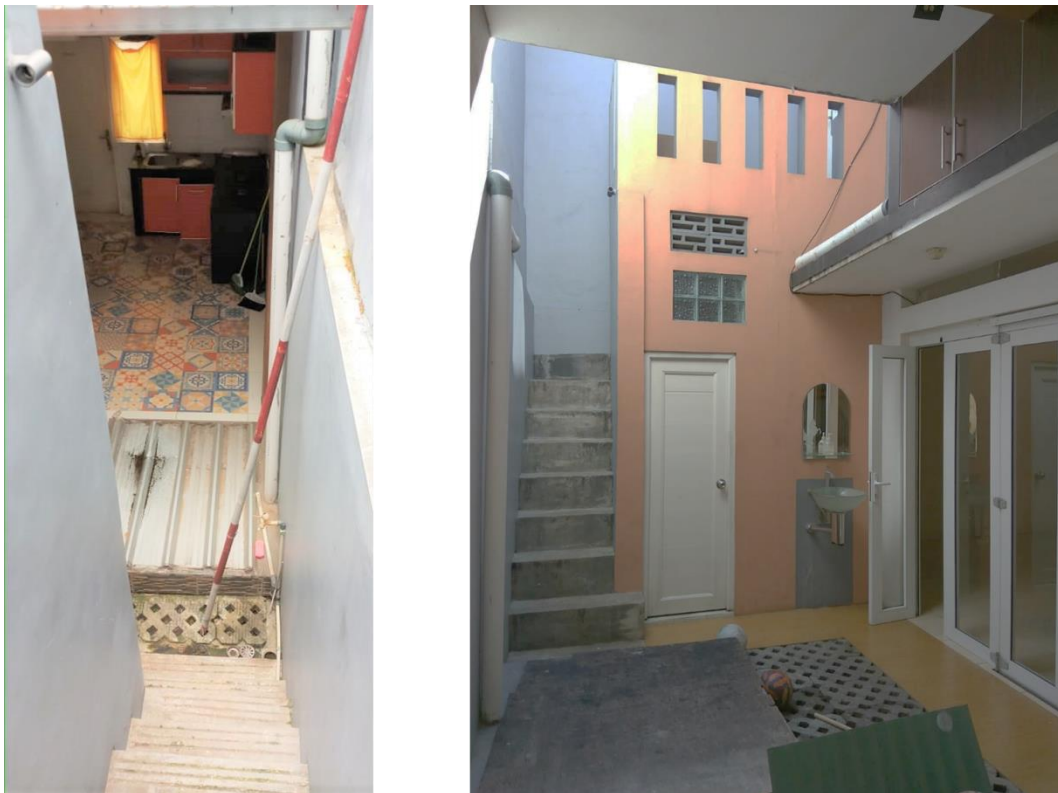
Gambar 15. Eksisting Void Proyek Rumah Tinggal
