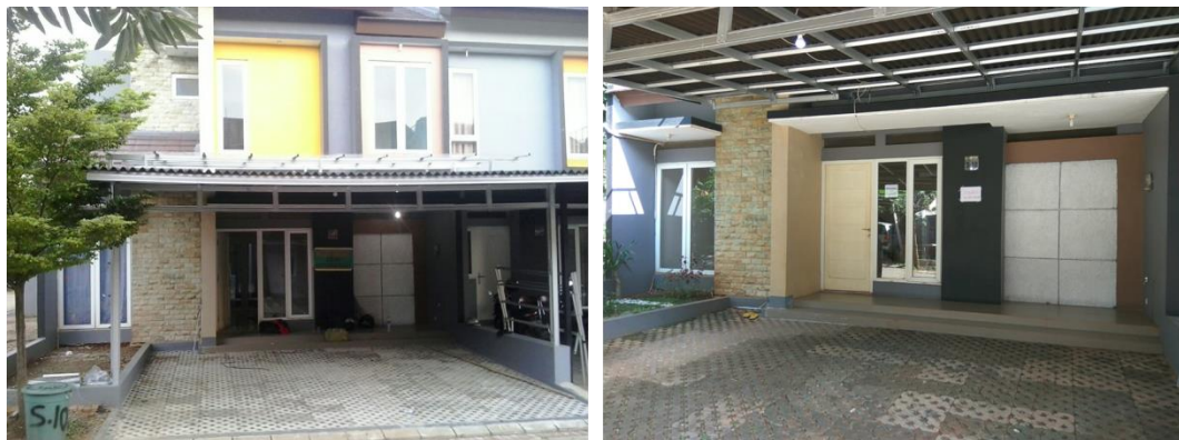
Gambar 13. Fasad Depan Eksisting Proyek Rumah Tinggal
