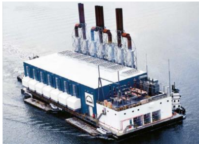
Gambar 1.3. Pembangkit Listrik Terapung Bentuk Tongkang Sumber : MAN Diesel & Turbo Floating Diesel Power Stations
