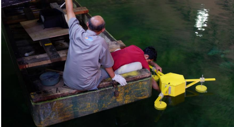
Gambar 32. Pemasangan single mooring
