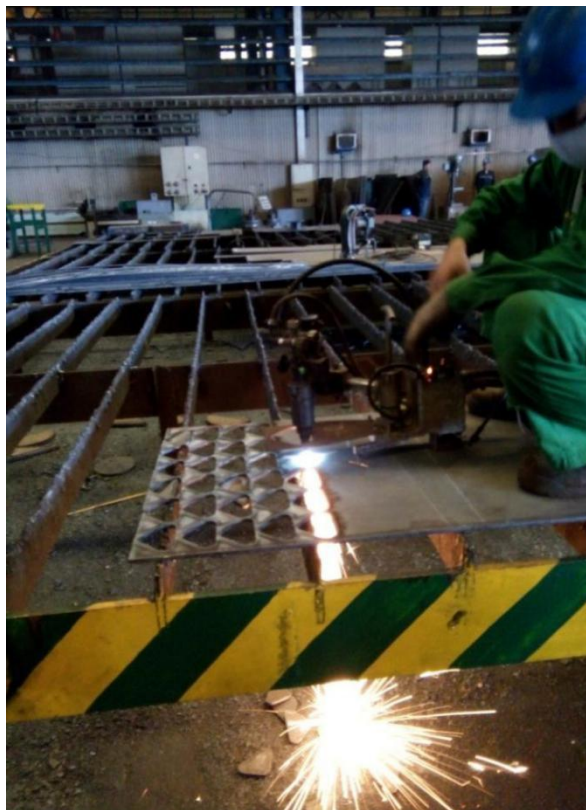
Gambar 4.1 Kondisi Pekerja saat Melakukan Cutting Material .
