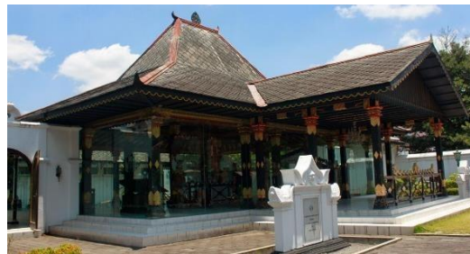
Gambar 4.3.10 : Atap berbentuk Joglo dan berdinding kaca (a. Sketsa Budaya, 2014);b. Dakung, 1987)
