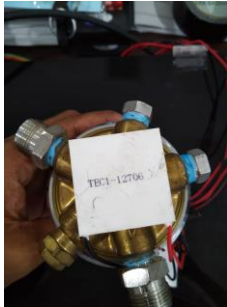
Gambar 4.11. Pemasangan Pemanas pada Regulator
