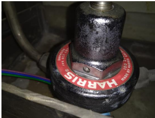
Gambar 4.9. Embun pada Regulator1
