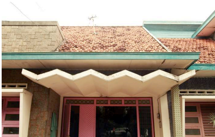
Gambar 5.4 Foto detail kanopi Jengki (sumber: Ramadhaniar, 2019)
