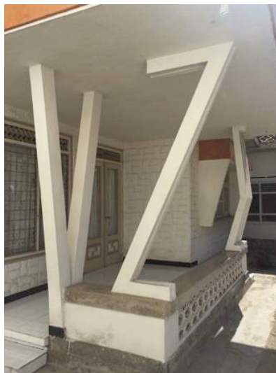
Gambar 4.8 Kolom dengan bentuk Z pada rumah Haji Fathollah (sumber: Residensi Jengki Madura, 2016)
