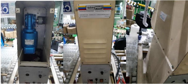
Gambar 4.5 Kegiatan pemasangan kerangka mesin dan memasukkan panel kontrol mesin di bagian bawah mesin
