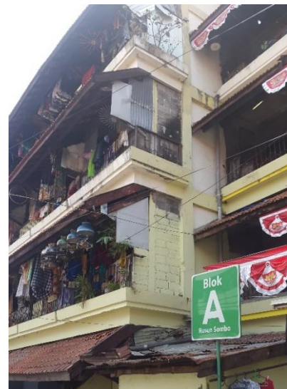
Gambar 1.34. Blok Pertama Rumah Susun Sombo (Arizaldi, 2019)
