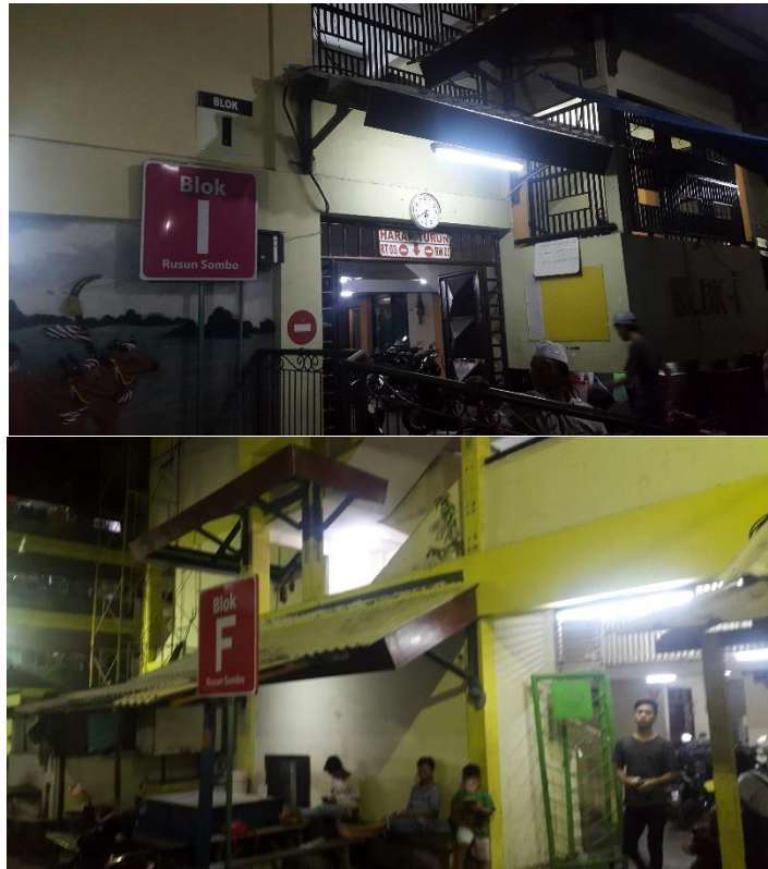
Gambar 1.12. Blok I dan Blok F Rusun Sombo (Arizaldi, 2019)
