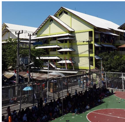
Gambar 1.5. Gedung Rusun dan Fasilitas Lapangan (Arizaldi, 2019)
