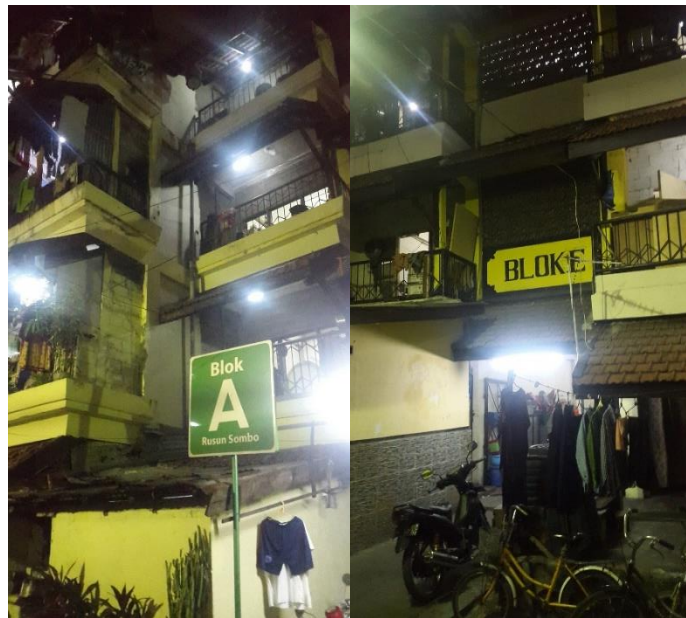
Gambar 1.10. Blok A dan Blok E Rusun Sombo (Arizaldi, 2019)
