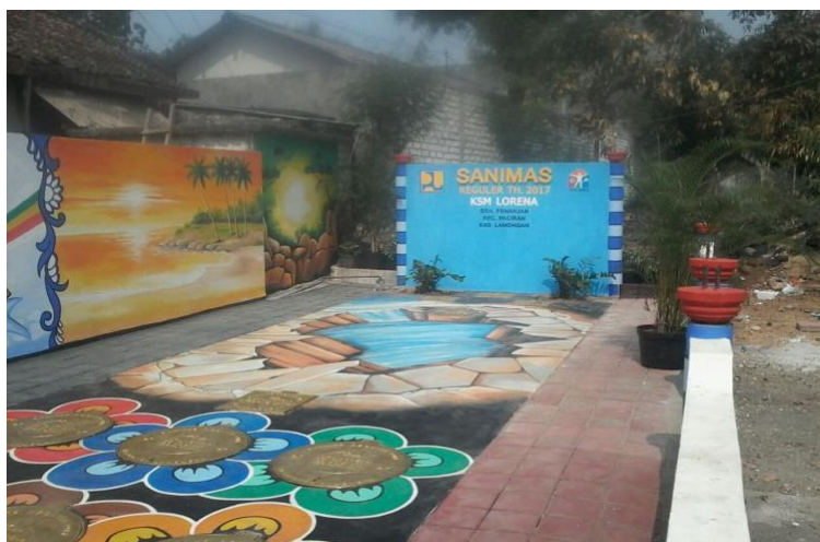
Gambar 3.2. Kondisi Eksisting IPAL Komunal Program Sanimas di Desa Paciran
