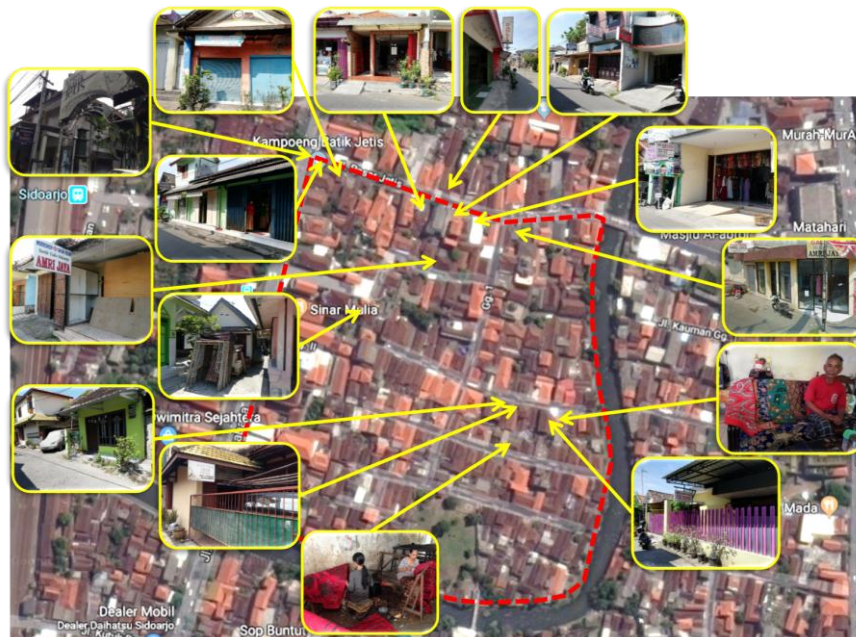
Gambar 1.1 Gambar lokasi dan lingkungan sekitar Kampung Batik Jetis Kabupaten Sidoarjo (Survey Primer, 2018)
