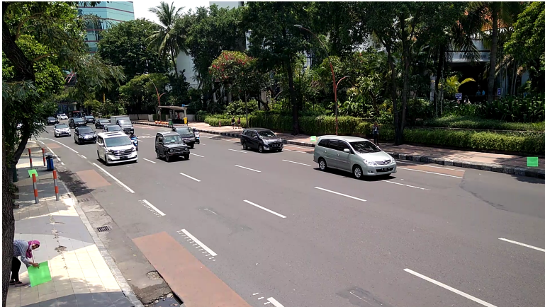
Gambar 3.17: Pemasangan penanda tampak dekat
