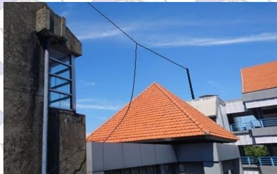
Gambar 3.7 Antena dipole horisontal pemancar di atas jembatan antar Gedung B dan AJ
