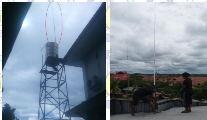
Gambar 3.16 Antena monopole vertikal sebagai penerima di Ternate (kiri) Merauke (kanan)
