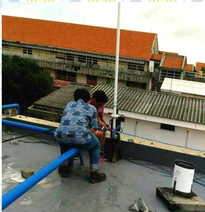
Gambar C.2 Pemasangan Antena Monopole di Gedung B lantai 4 Departemen Teknik Elektro ITS Surabaya
