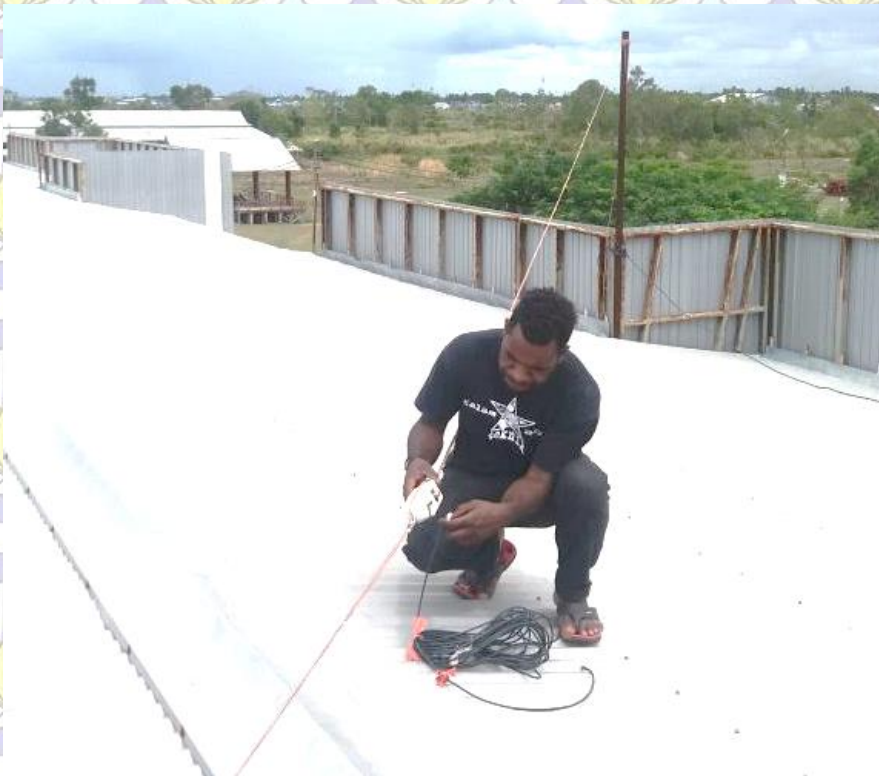
Gambar C.4 Pemasangan antenna dipole diatas atap Lab Teknik Elektro, Universitas Musamus, Merauke
