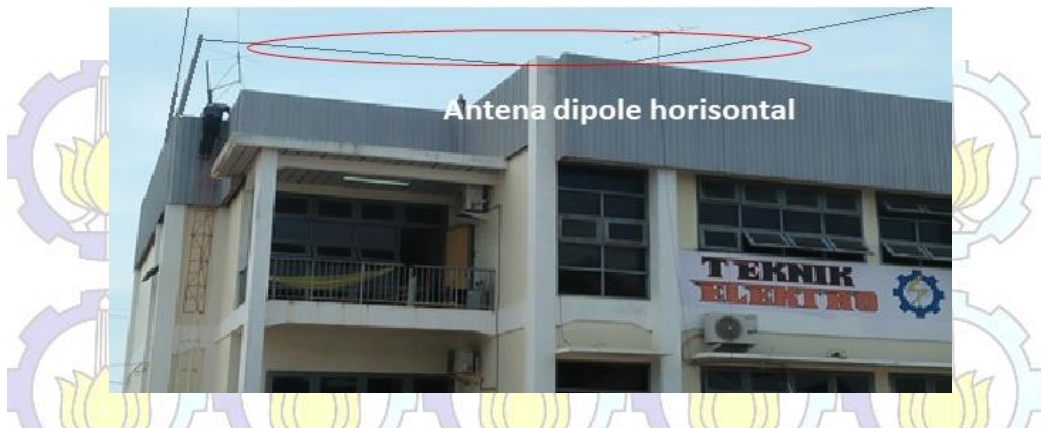
Gambar 3.8 Antena dipole horisontal sebagai penerima diatas Gedung Teknik Elektro, Universitas Musamus, Merauke
