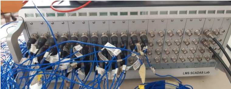
Gambar 3.3 Sambungan kabel pada frontend LMS SCADAS SCL220
