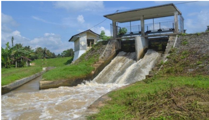
Gambar 1.4 Pintu sadap Saluran Irigasi Mataram II ( Van Der Wijck ) (Sumber: dok Titis, 2014)
