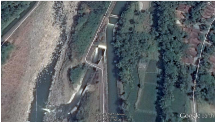
Gambar 1.3 Pintu sadap Saluran Irigasi Mataram II ( Van Der Wijck ) (Sumber: Google Earth, 2014)
