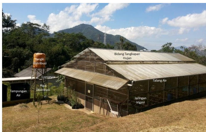
Gambar 3. Sistem Pemanenan Air Hujan pada Greenhouse
