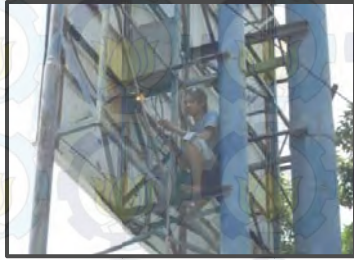
Gambar 4 : Pengambilan Benda Uji Baja di Lapangan
