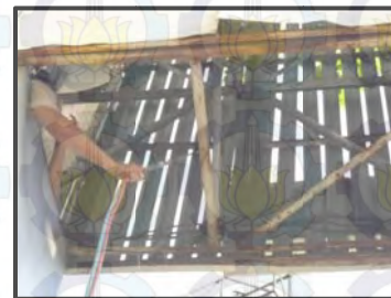
Gambar 9 : Korosi Pada Rangka Papan Reklame
