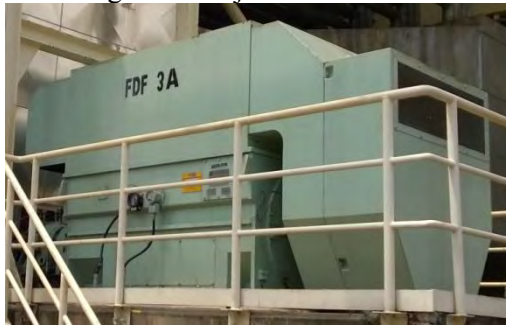
Gambar 23 Forced Draft Fan PLTU Unit 3A (Sumber: Dokumentasi Penulis, 2015)
