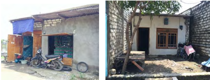
Gambar 4.7 Kondisi Bangunan Permukiman Kumuh di Kelurahan Tambak Wedi
