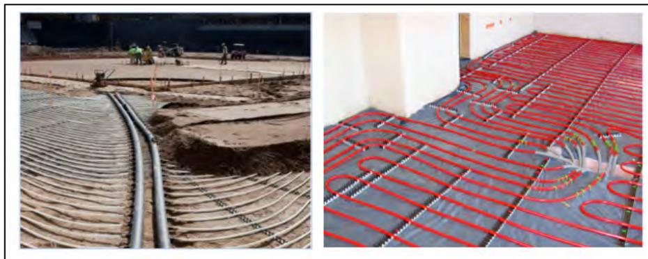
**Gambar 2.8** Pipa PEX pada Lantai Rumah (kiri) dan Pipa PEX pada Lapangan (kanan)
