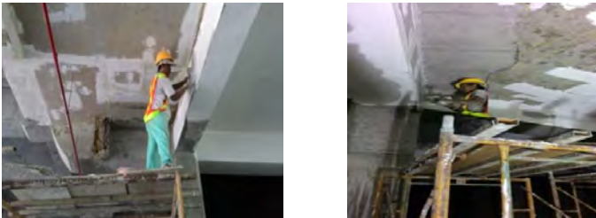
Gambar 4.8 Pekerjaan Pengecatan di Area Basement
