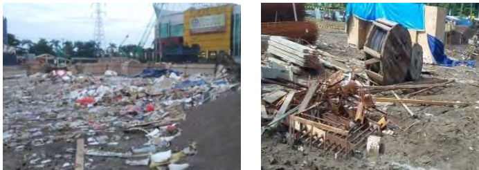
Gambar 4.18 Sampah Padat dari Hasil Aktivitas Konstruksi Sumber : Dokumentasi Lapangan, 2016
