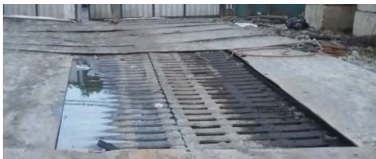
Gambar 4.21 Kolam Pengendapan untuk Aktivitas Pembersihan Kendaraan ( Washing Bay )
