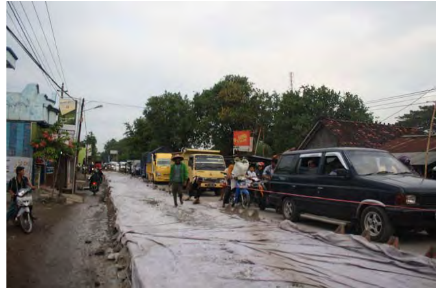
Gambar Perbaikan Jalan Demak-Trengguli (Sumber :wargademak.com)
