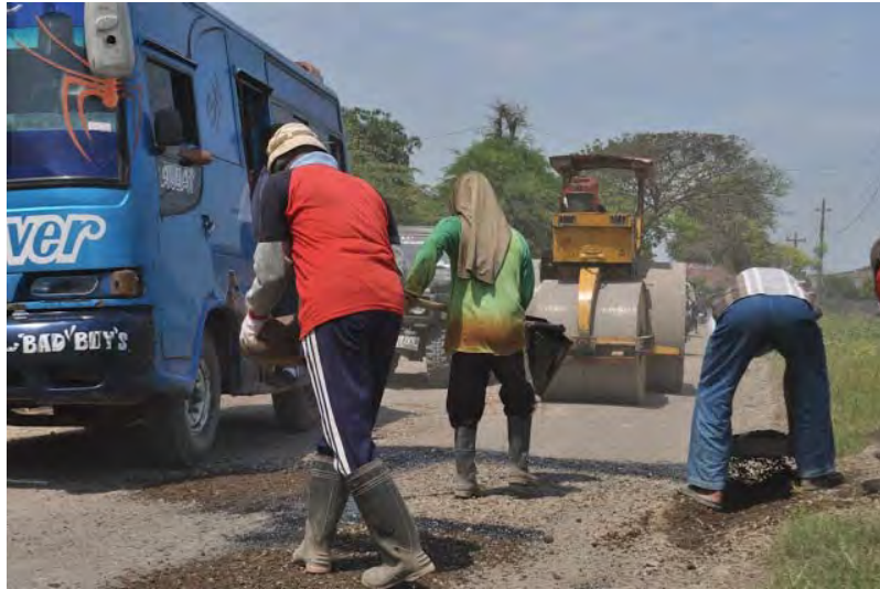
Gambar Perbaikan Jalan Demak-Trengguli (Sumber :wargademak.com)
