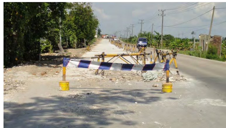
Gambar Perbaikan Jalan Padangan-Ngawi (Sumber :metro-times.com)
