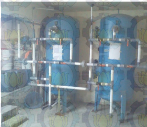
Gambar 3.6 Bak Pengendap dan Tangki Filter
