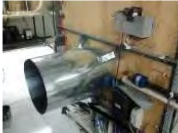
Gambar 3.11 Fan dan ducting pengeluaran kalor kondensor high stage
